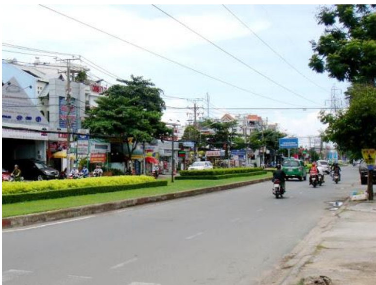
Đường Trần Nãi with 4 lanes.
